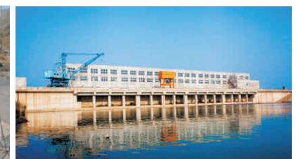
真纳项目现场 JINNAH project site
