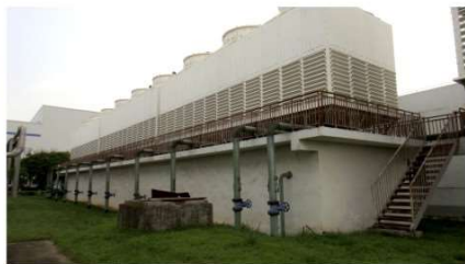
透平循环水泵房（小机试车）
